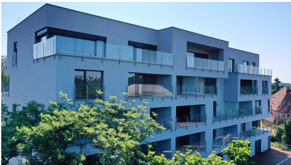
Obrázek 1 Fotografie realizovaného projektu „Novostavba domu Hippokrates“.
